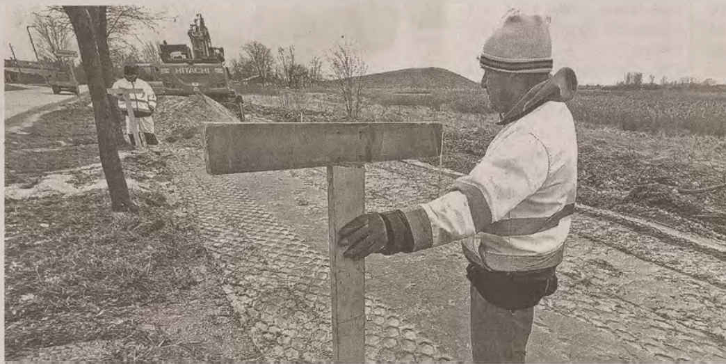
Szintezik az útalapját az összesen 2175 méteres, egy év alatt megépülő kerékpárútnak
